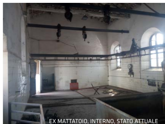
EX MATTATOIO, INTERNO, STATO ATTUALE
